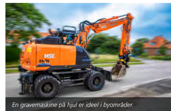
Der graves ud til 32 km fjernvarmeledning.
