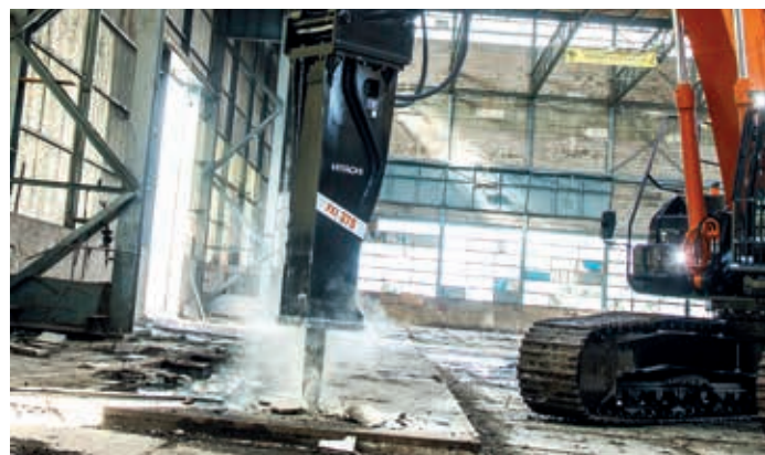
Hitachi-hamre er lette i vægt med høj slagkraft.
