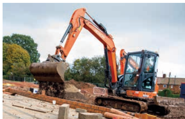
Zaxis små gravemaskiner
