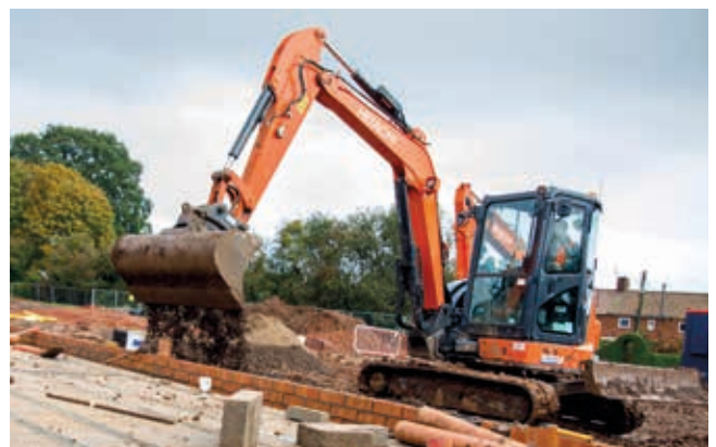
Zaxis små gravemaskiner
